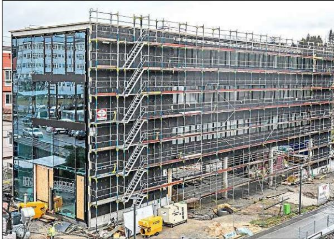
Imposant präsentiert sich das neue Gründerzentrum Digitalisierung, das von der Innstraße her gesehen eine große Glasfassade ziert. – Fotos: Jäger
